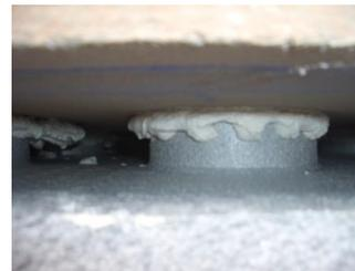
*Detalle de tetones separadores para la generación de cámara de aire*
