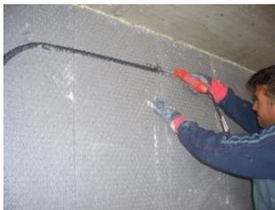
*Ejecución de rozas con cortador térmico*
