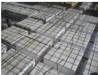
Casetones y armado de la capa de compresión
