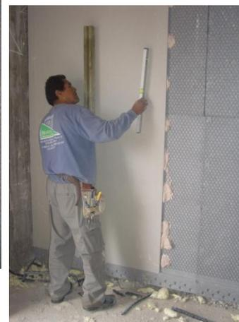
*Fijación de la placa de yeso y comprobación del nivel*
